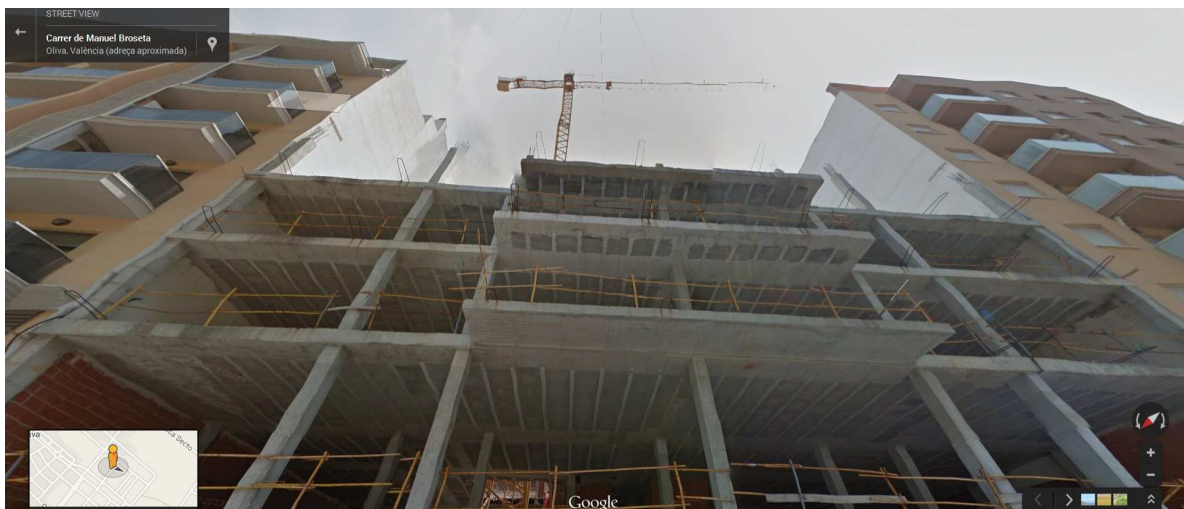
Grua torre de Manuel Broseta 52, objecte de l'Ordre d'Execució 106/13
