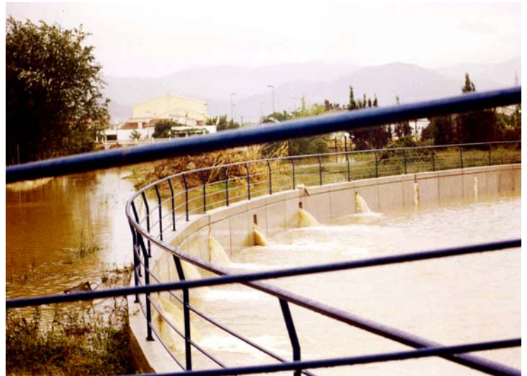
1996. Marge dreta del nou canal del Alfadali-Sequia Mare.jpg
