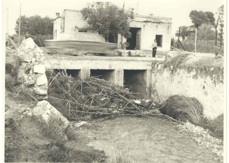
1972. Pont CN-332 sobre Alfadali 1 .jpg
