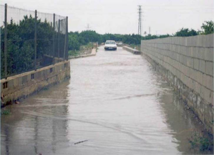
1996. Camí Vell de Piles 1 .jpg
