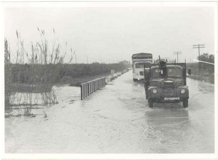
1972. Gallinera sobre CN-332 2 .jpg
