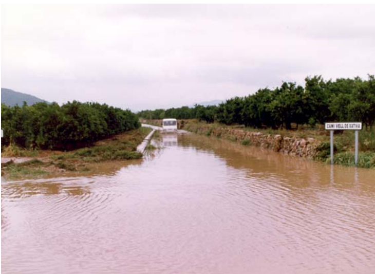
1997 juny. Desbordament de la sequia mitjana-Barranc de la Font sobre el Camí Vell de...
