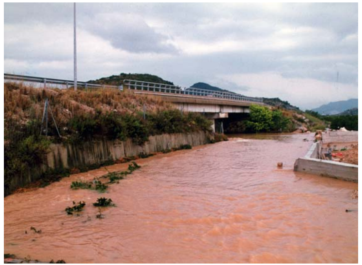
1997 juny. Desbordament de la sequia mitjana-Barranc de la Font sobre el Camí de la ...
