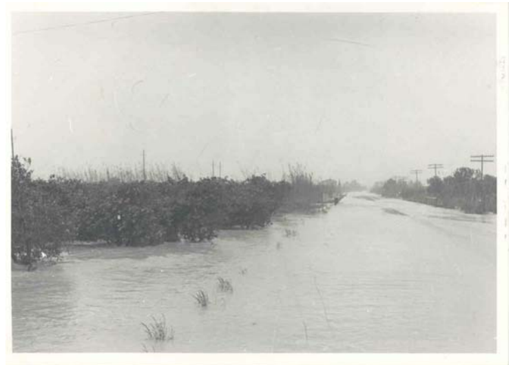
1972. Gallinera sobre CN-332 1 .jpg
