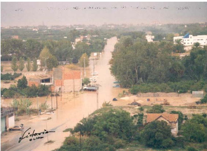
1987. Carretera de Oliva al Mar 3 .jpg
