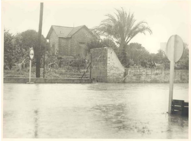
1972. Carretera Oliva al Mar 1 .jpg
