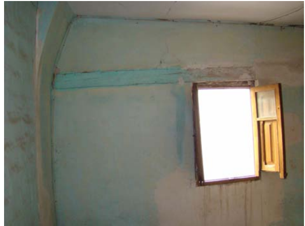
Vista de l'arc costat dret. Casa nº10.
