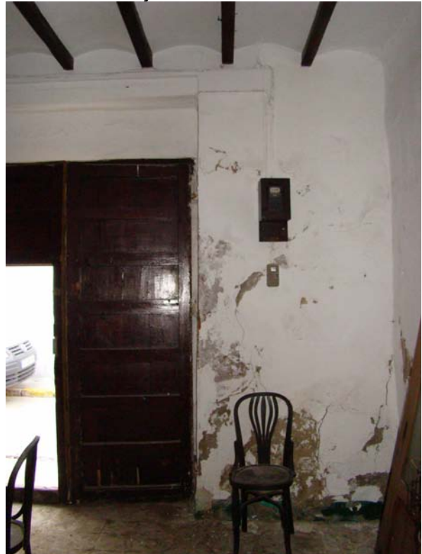
En la imatge es veu com ha rebentat la lluïda en la base de la pilastra.
