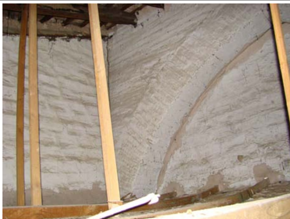
Sistema horitzontal del fals sostre.
