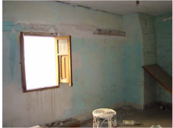
Vista de l'arc costat dret. Casa nº14.
