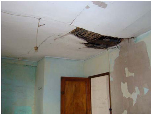
Sostre deformat i arruïnat
