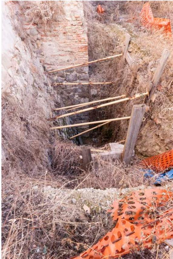
Imagen detalle de la cata sobre el muro del foso del Palau Comptal.
